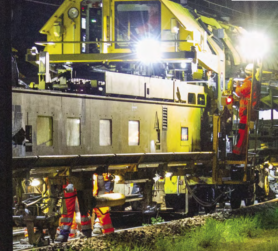
LA BOURREUSE VIENT RÉGLER LA GÉOMÉTRIE DE LA VOIE
