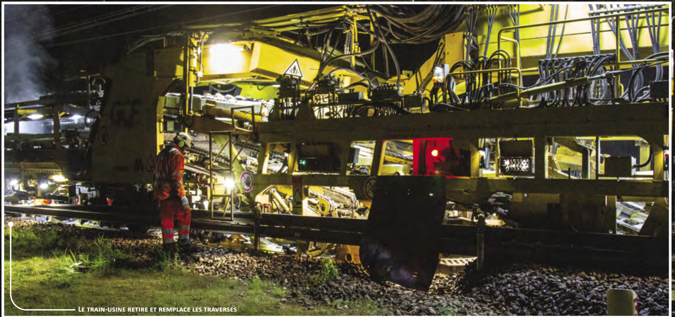
LE TRAIN-USINE RETIRE ET REMPLACE LES TRAVERSES
